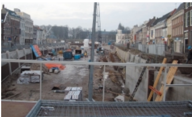
Le canal de Breda en réfection.
