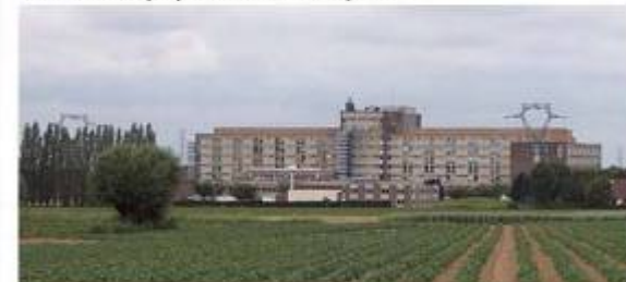
Grands équipements : hôpital
