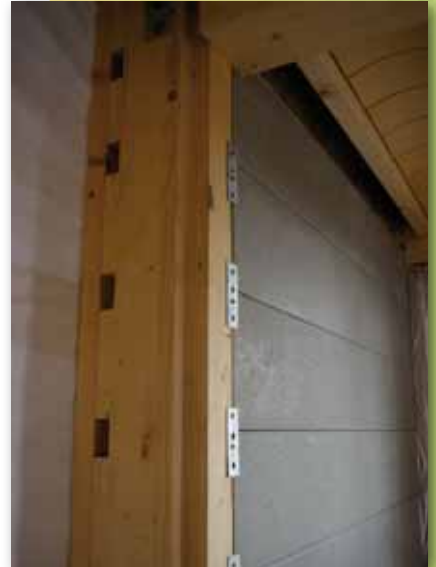
21 tonnes de masse thermique régulent la température à l'intérieur de la maison.
